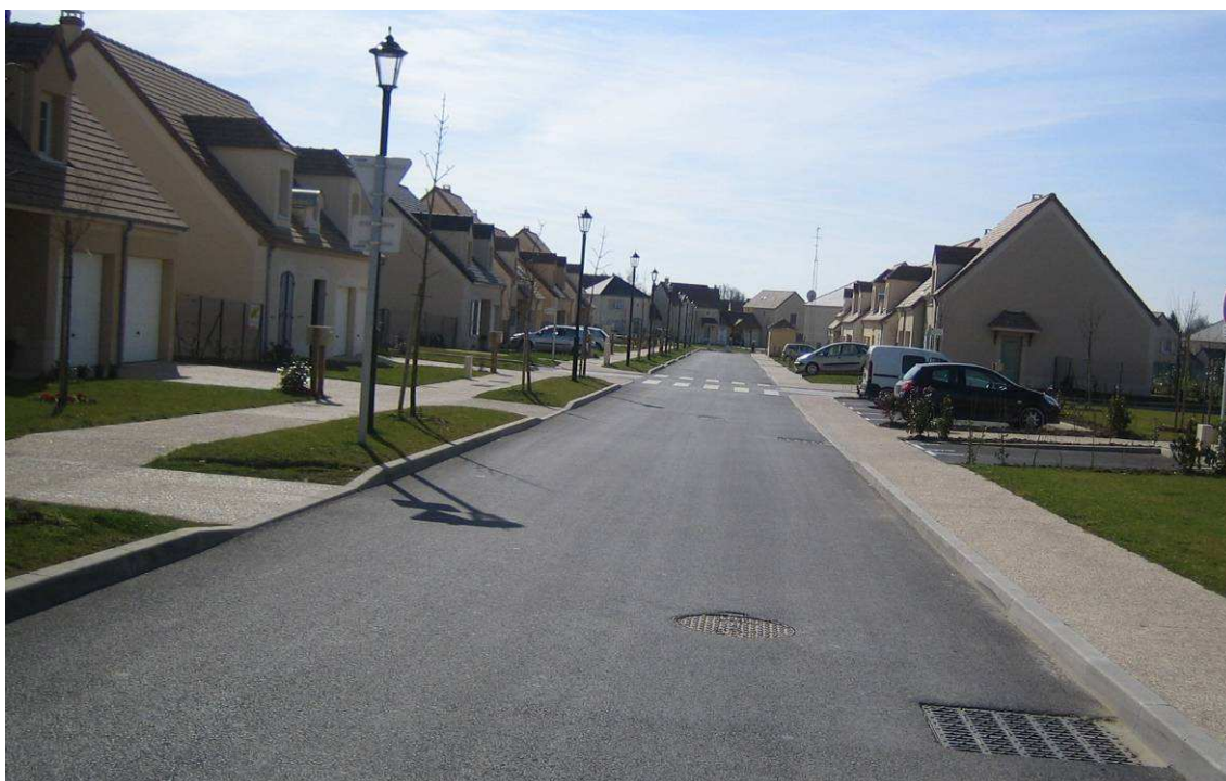
Photo 42 : Chaussée réservoir du Domaine du Château
