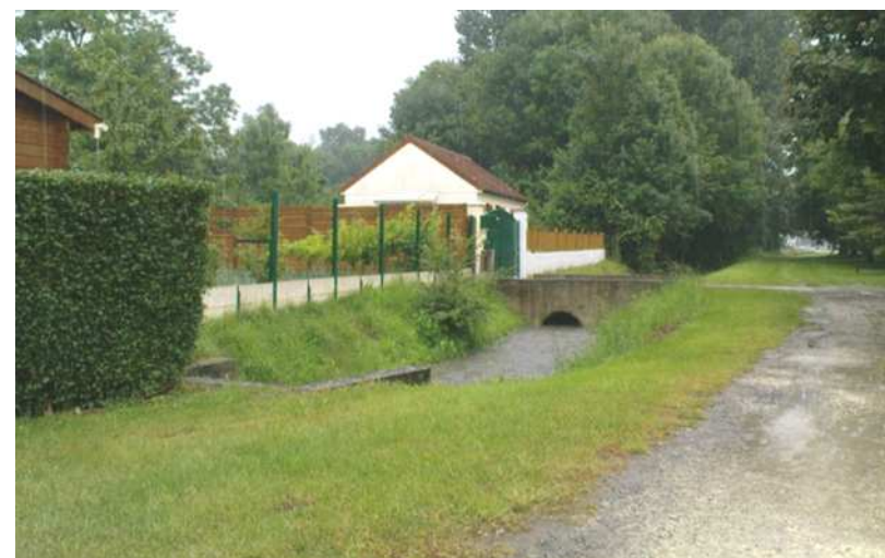
Fossé du clos des Têtes (SODEREF, 26/06/2009)
