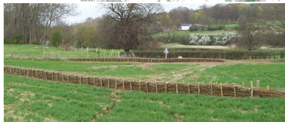
Barrages en fascine en fond de vallon
