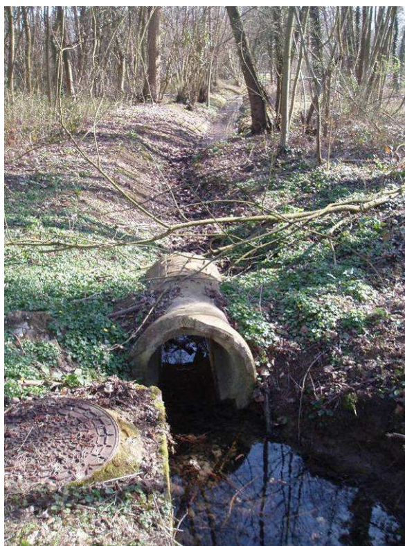
Photo 47 : Fossé des Chardonnais
