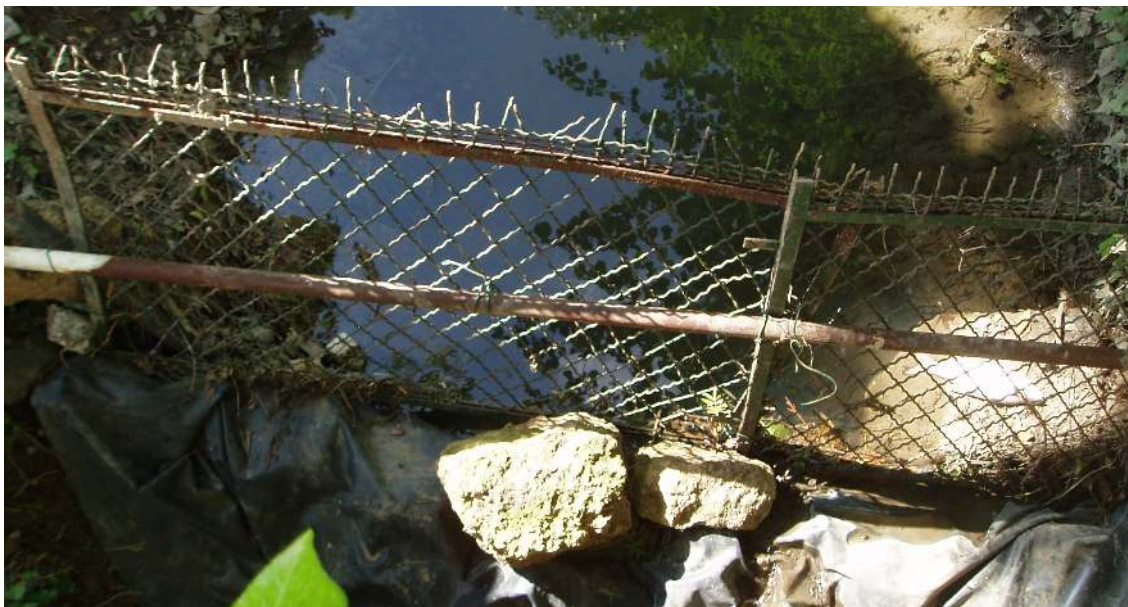
Photo 25 : Barrage observé dans le fossé des Gorres au niveau du chemin du Souage
