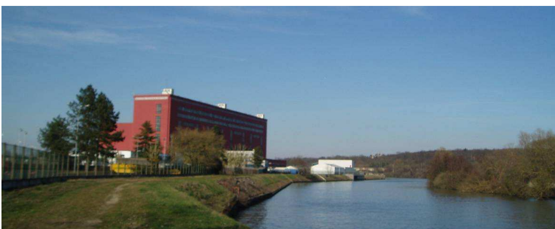
Photo 5 : site industriel implanté en bordure de l'Oise
