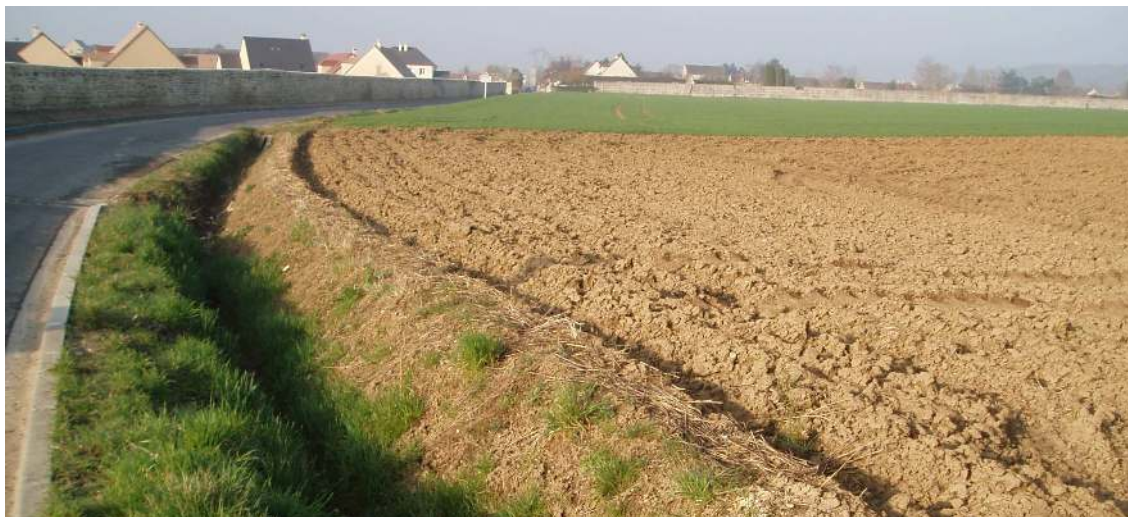
Photo 41 : Fossé sur la route départementale 92 mis en place par la mairie suite à la construction du Domaine du Château
