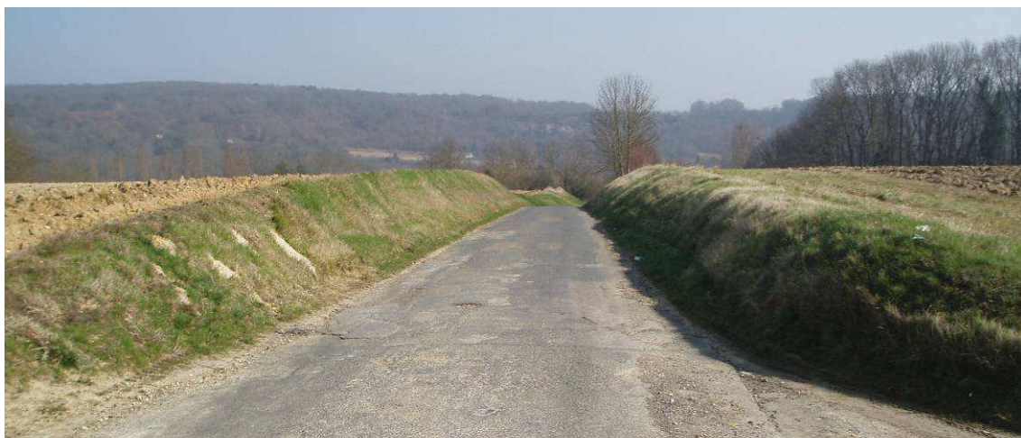
Photo 22 : Amont du chemin de Crouy en Thelle
