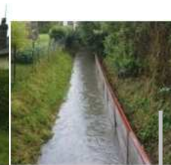
Fossé du Castel 3
