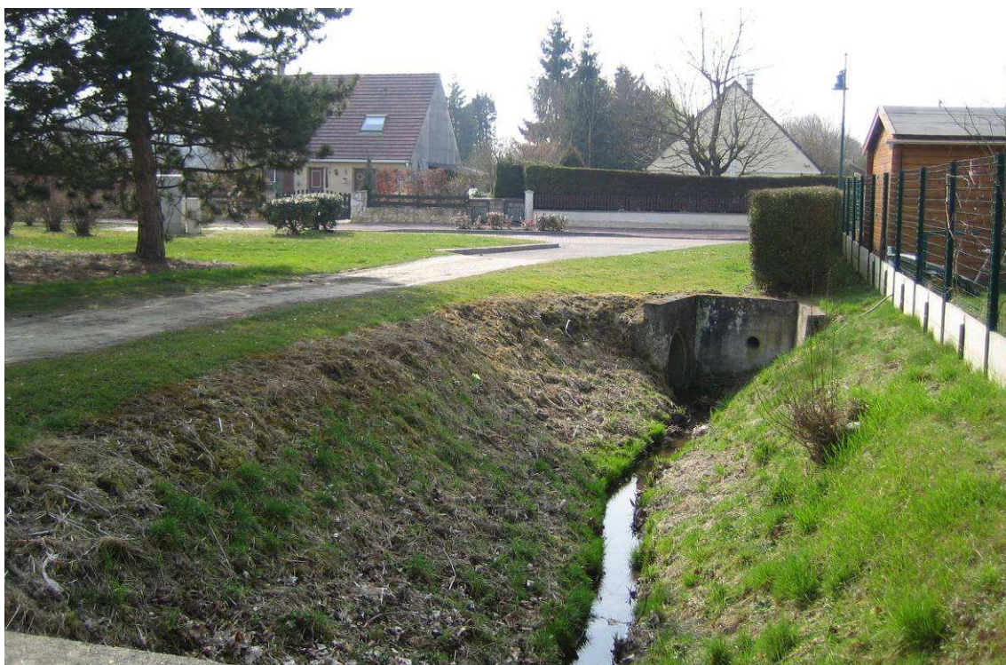
Photo 46 : Fossé prolongeant le Castel le long de la CD 92 à proximité du poste de refoulement des étangs avant busage
