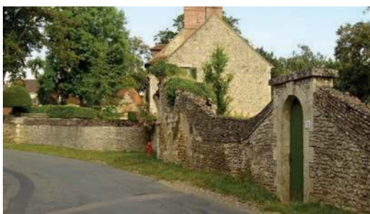
Murs en moellons en limites de propriétés et rue sinueuse, Mouchy-le-Châtel
