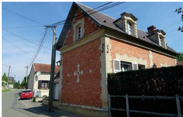
Maison disposant de façades composées par des appareillages associant briques et pierres
