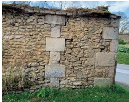
Mur de clôture, Abbecourt
