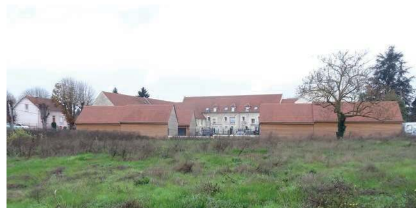
Réemploi d'un ancien corps de ferme en centre bourg, Morangles
