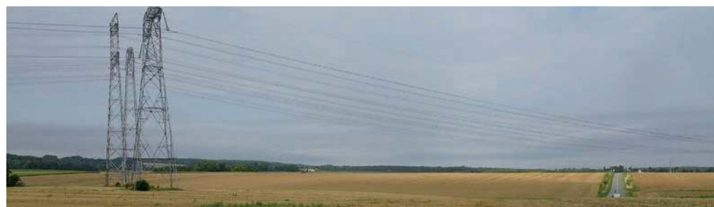
Lignes à haute tension visibles depuis la RD 137, entre Noailles et Mouchy-le-Châtel
