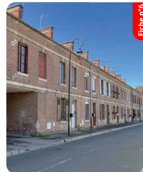
Les maisons de l'ère industrielle
